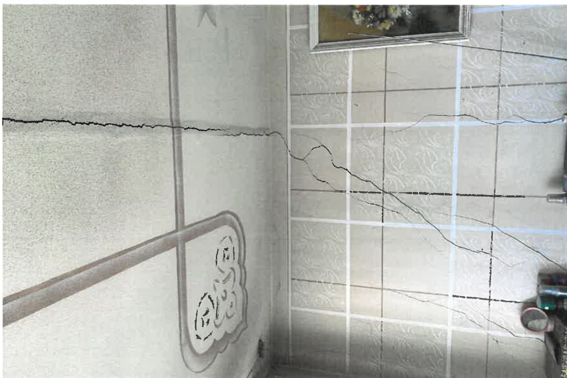
Pav. 12 Įstriži plyšiai atitvarinės laikančiosios sienos tinke
