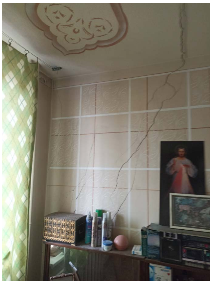
Pav. 44 Pažaidos, įtrūkimai sienose ir tarp perdangos plokščių, bute
