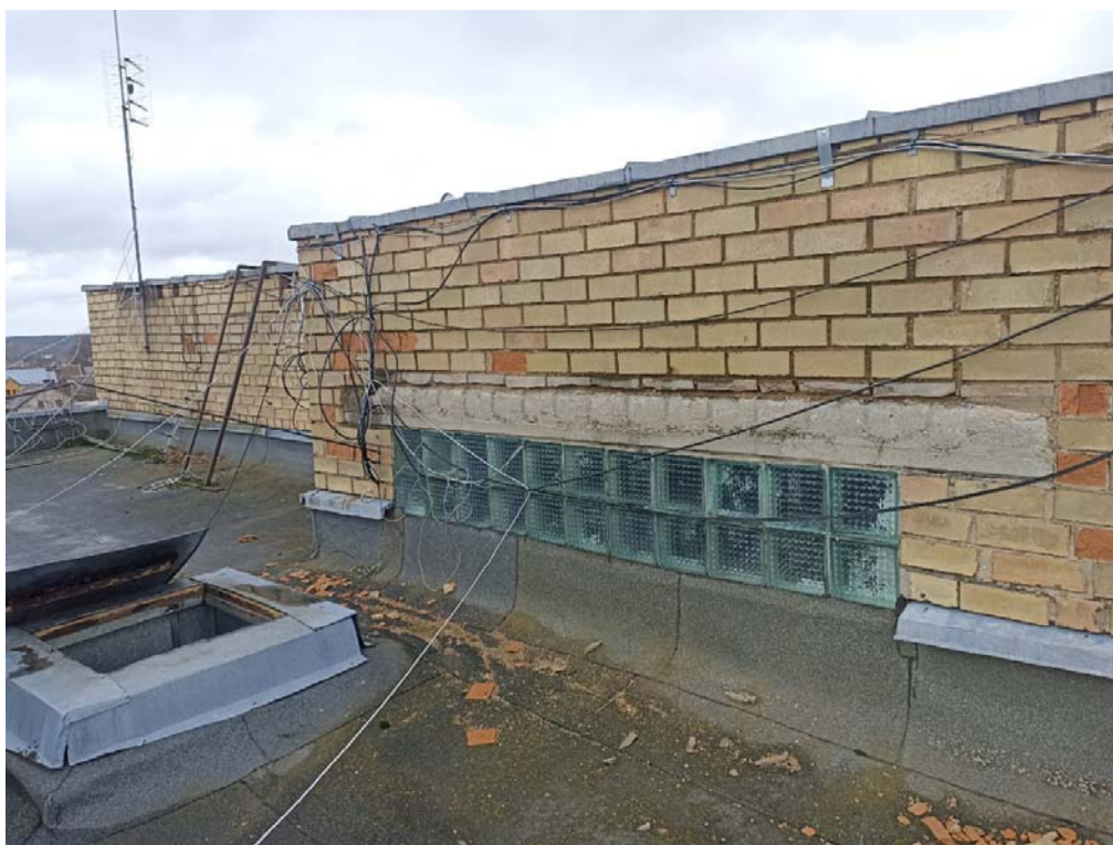
Pav. 46 Lokaliai plytų mūro pažaidos. Vaizdas ant stogo
