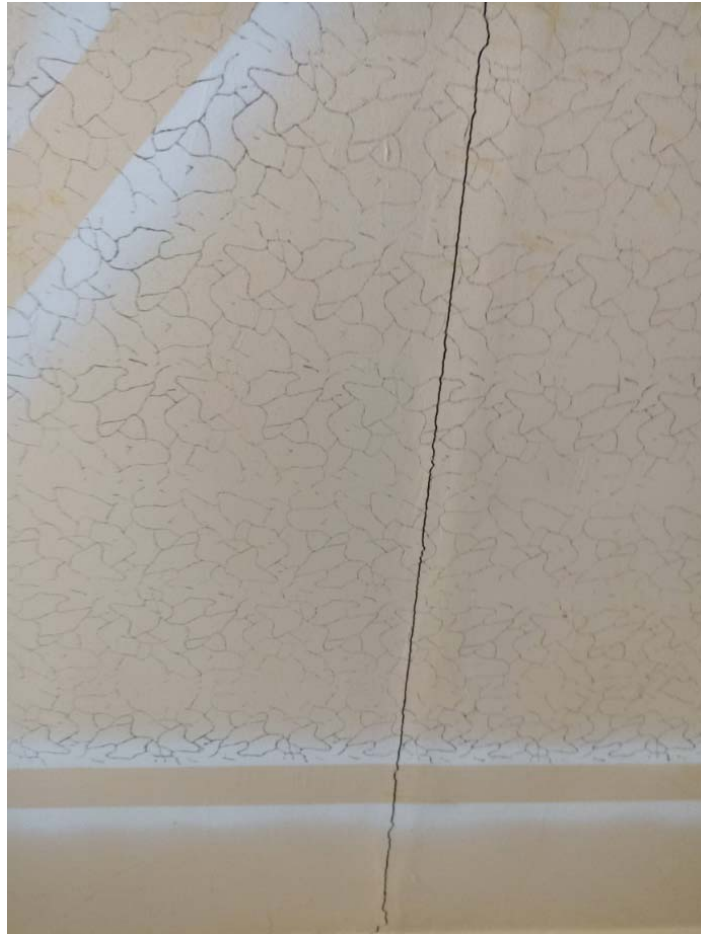
Pav. 43 Pažaidos, atsivėrę plyšiai tarp perdangos plokščių, bute
