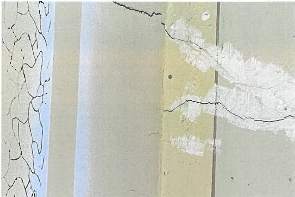
Pav. 11 Vertikalus plyšys atitvarinėje laikančiojoje sienoje ir tarp perdangos plokščių
