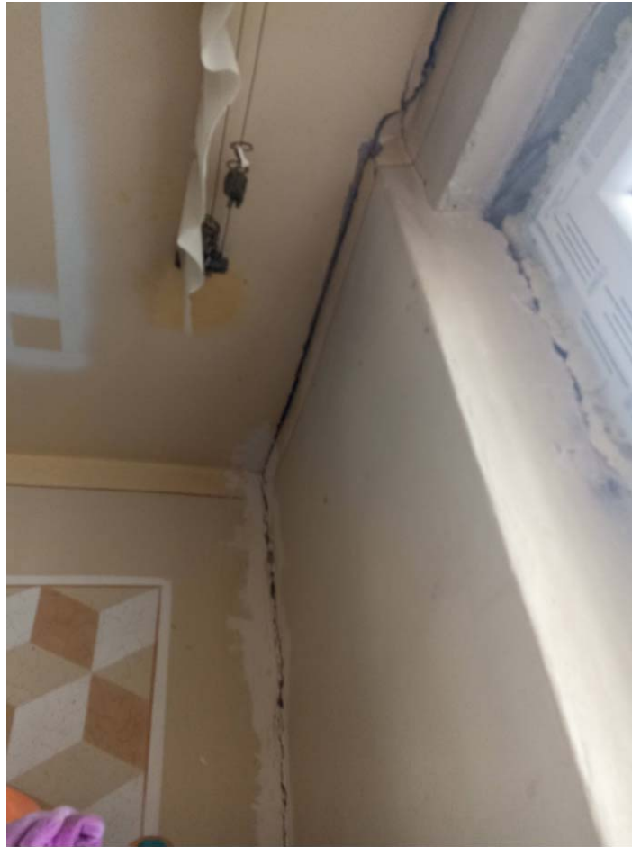
Pav. 41 Pažaidos, atsivėrę plyšiai tarp perdangos plokštės ir išorinės sienos, bute
