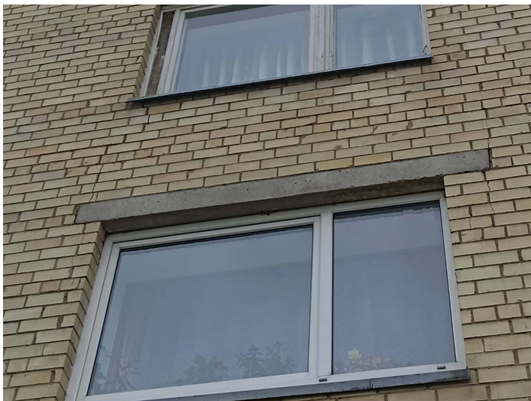
Pav. 14 Sienų pažaidos, įtrūkimai ties sąramom
