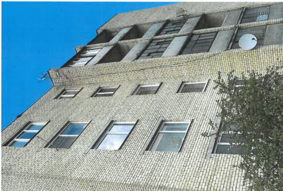
Pav. 3 Fasado fragmentas su mūro po sąramomis ir balkonų plokščių pažaidomis
