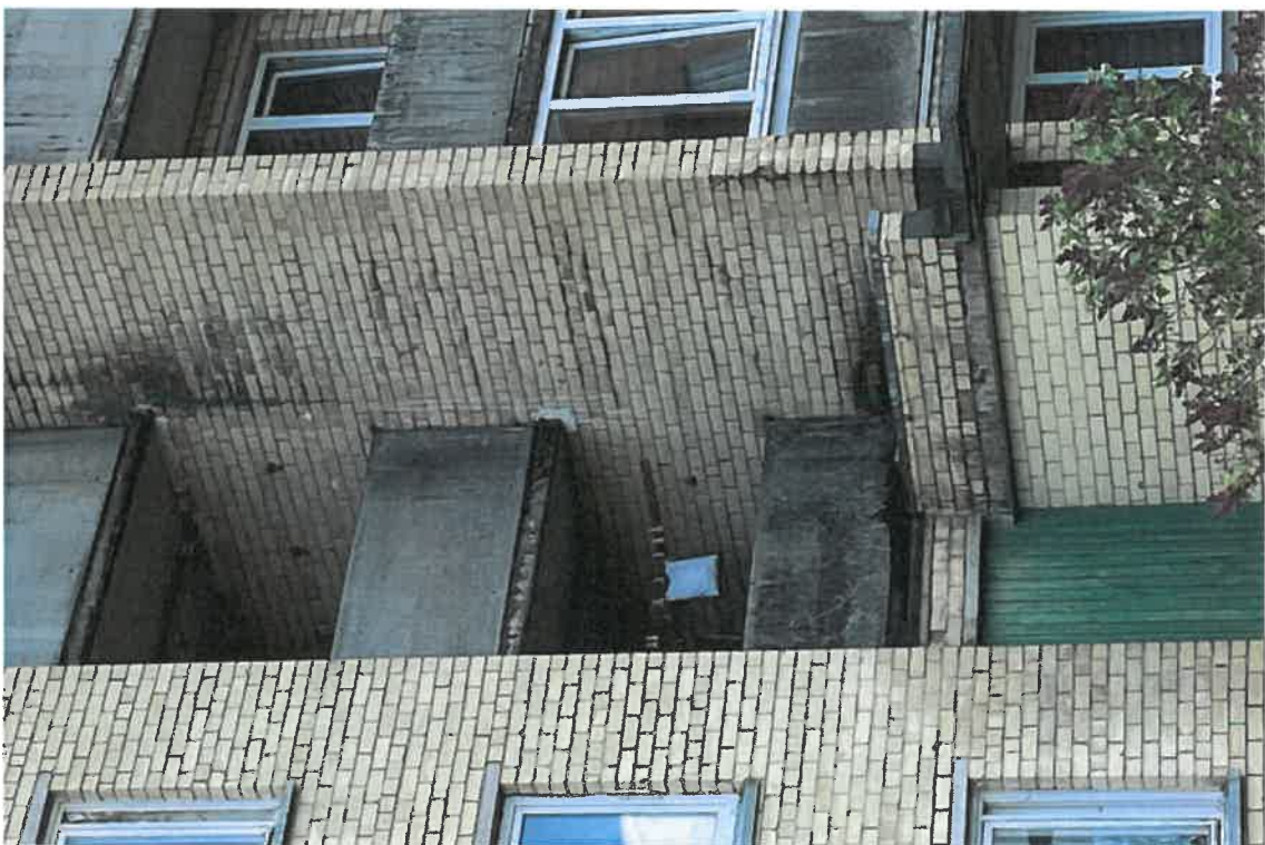
Pav. 8 Fasado fragmentas su sienų ir balkonų plokščių pažaidomis
