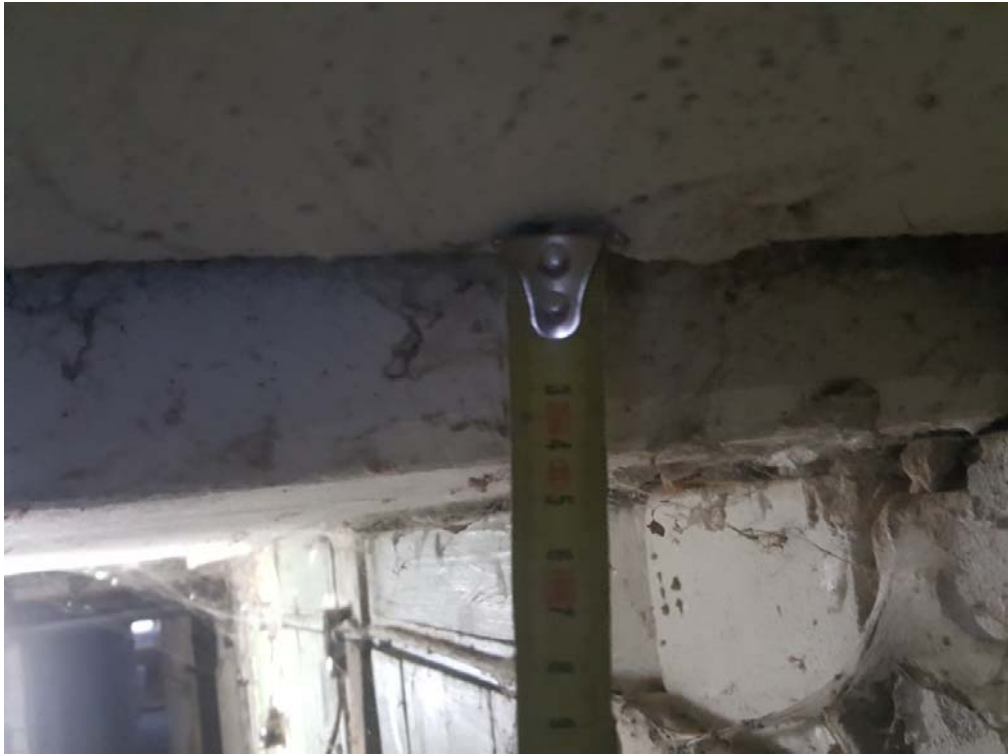
Pav. 37 Vaizdas rūsyje tarp gretimų surenkamų perdangos plokščių
