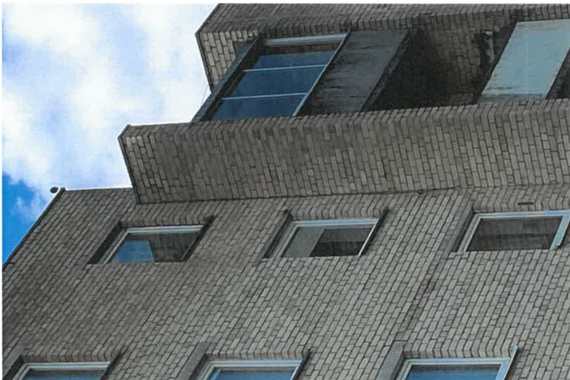
Pav. 2 Fasado fragmentas su parapetų ir balkonų plokščių pažaidomis
