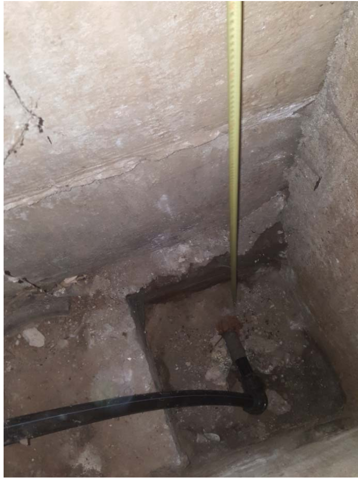
Pav. 49 Pamatų vaizdas rūsio patalpos R-28 prieduobėje (vandentiekio įvadas)
