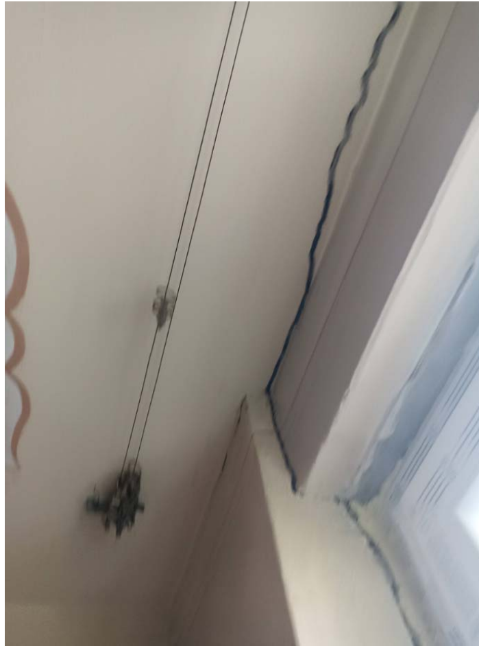
Pav. 45 Pažaidos, atsivėrę plyšiai tarp perdangos plokštės ir išorinės sienos, bute
