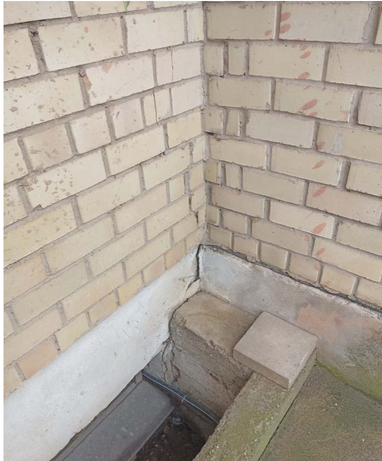
Pav. 17 Sienų pažaidos, įtrūkimai cokolyje
