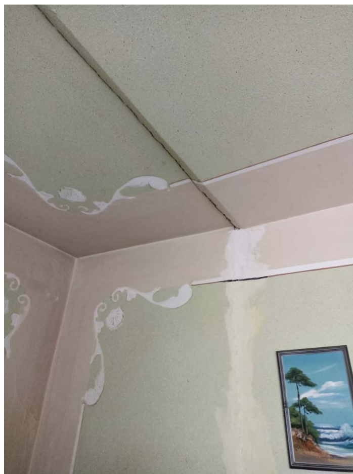
Pav. 40 Pažaidos tarp perdangos plokščių, bute
